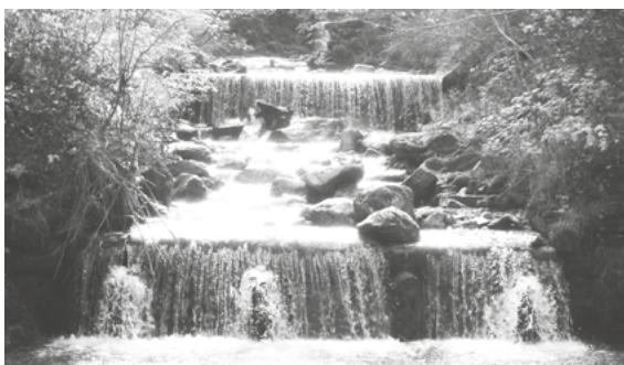
Seuils dans la Dixence
