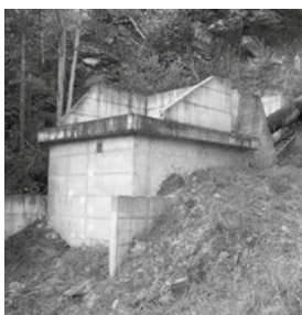
Puits de la conduite forcée
