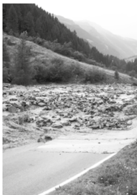
Route obstruée par la lave torrentielle de 2006
