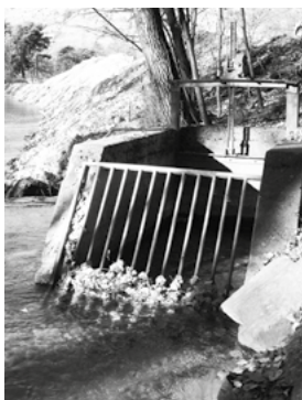
Prise d'eau secondaire
